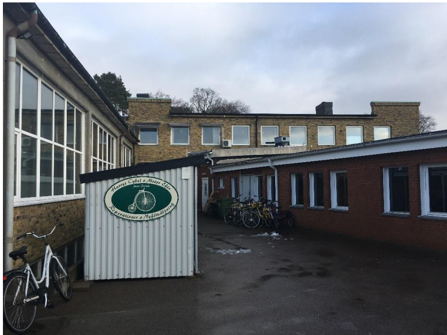
Figur 31 Verkstaden till vänster och baksidan på bilförsäljningen rakt fram. Notera hur fasadmuren går upp för att ge intryck av att taket är helt plant.
