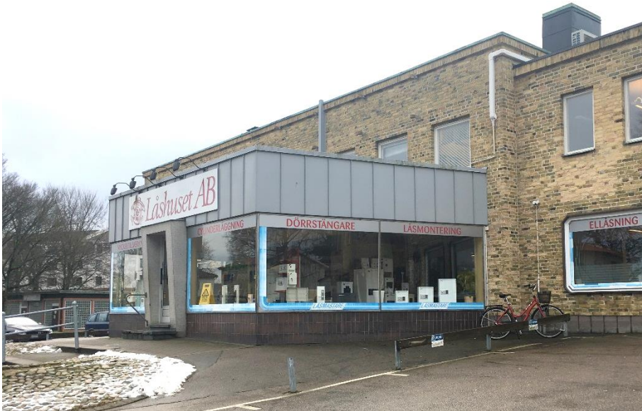
Figur 19 Den utskjutande butiksdel. Notera de smäckra fönsterpartierna och den relativt nya plåttäckningen.
