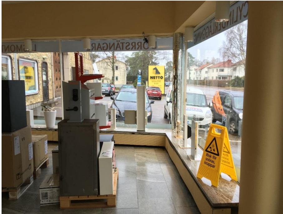
Figur 39 Butiksdelens insida, notera den smäckra pelaren i hörnet samt golv och fönsterbänkar i marmor.
