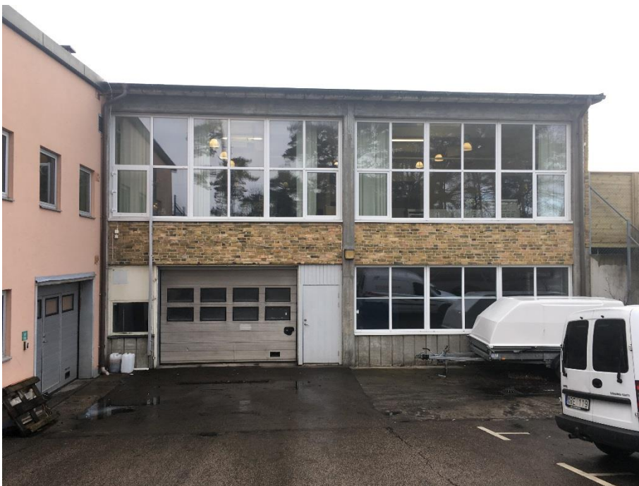
Figur 29 Verkstadens fasad mot nordväst, utbyta fönsterpartier.
