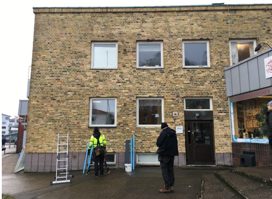
Figur 18 Bostadsdelen med egen ingång, dörren utbytt och fönsterbyte pågår. Originalfönster i ovanvåning och nya i bottenvåning.
