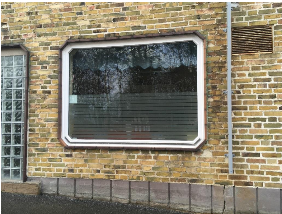
Figur 20 Fönster med avfasade hörn i omfattning med höganäsklinker. Notera också den räfflade sockeln.
