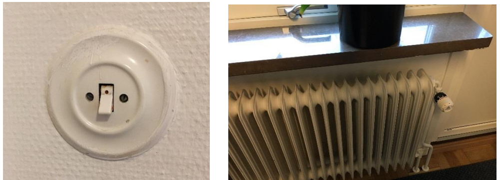
Figur 42 Tidstypiskt strömställare tv och sektionsradiator och fönsterbänk i kalksten th.
