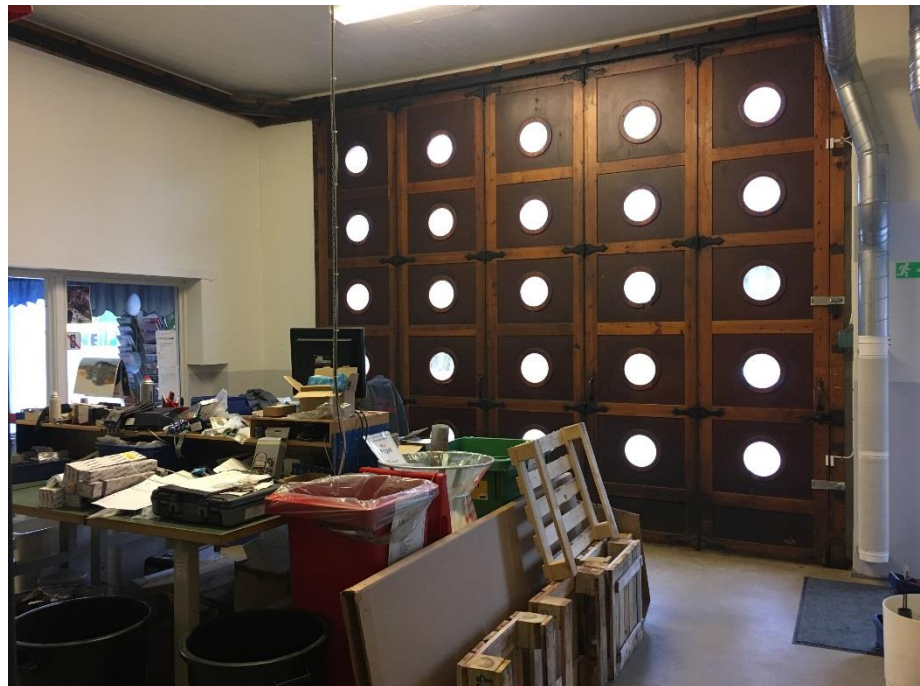
Figur 34 Vikporten insida. Här var tidigare infarten men idag är det kontor, trots det har porten bevarats och går fortfarande att dra åt sidan, notera rälsen i taket.
