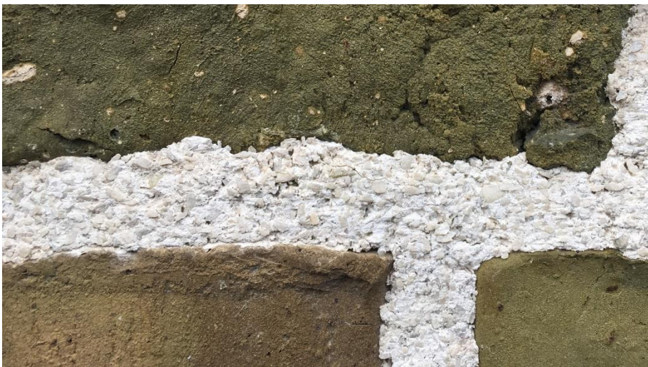
Figur 25 Genomfärgat fogbruk med marmorkross.
