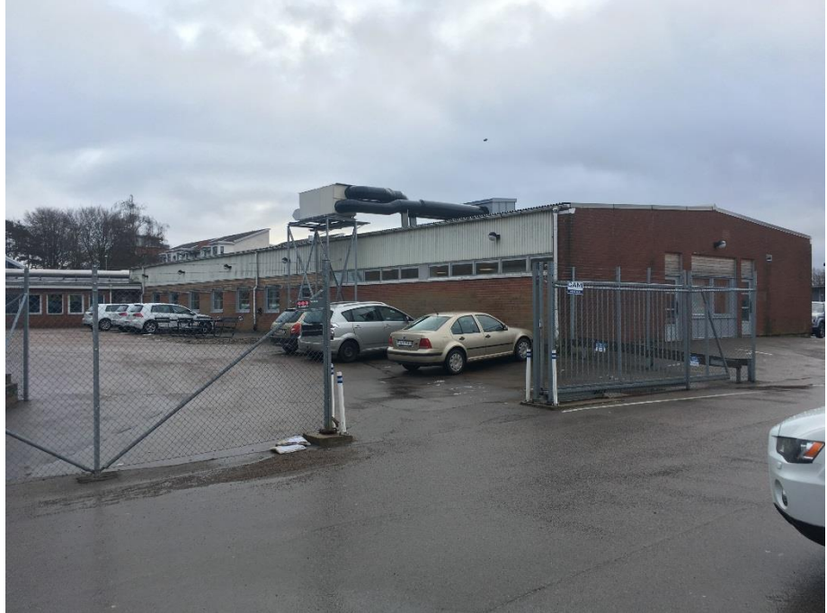
Figur 45 Del av gården på fastigheten Körsbärsträdet 6. Gården präglas av asfalt, stängsel, komplementbyggnader och parkering.
