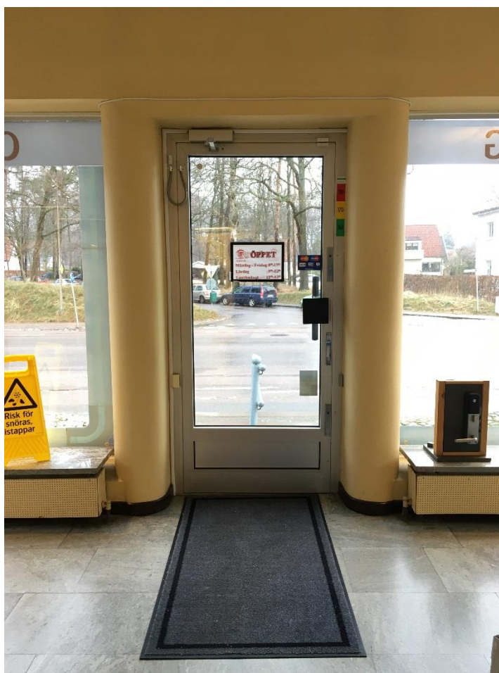
Figur 38 Butiksdelens entré från insidan. De båda runda pelarna bär taket och innehåller också stuprören.
