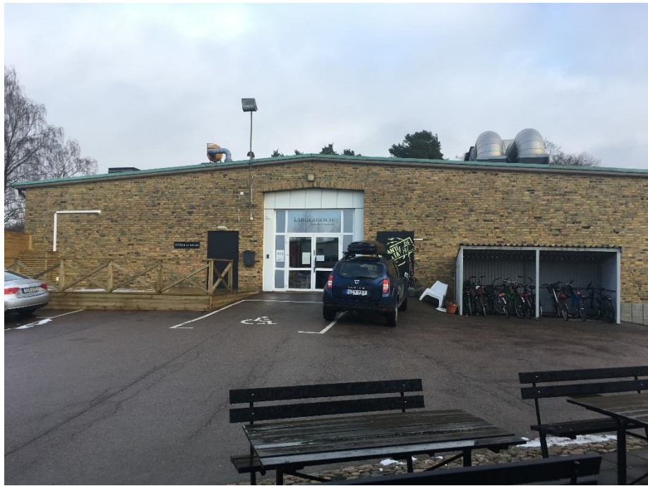
Figur 30 Verkstadens fasad mot sydväst med utbytt port.
