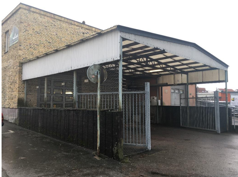
Figur 26 Gavel mot nordväst med skärmtak till smörj- och tvätthall.
