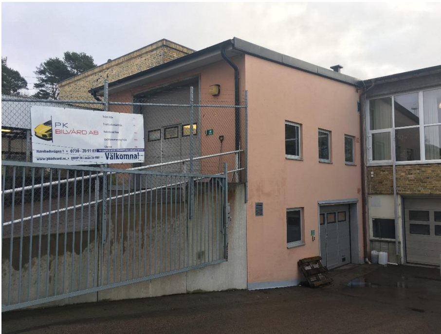
Figur 28 Tillbyggnad från 1997 där färgsättningen bör ändras.
