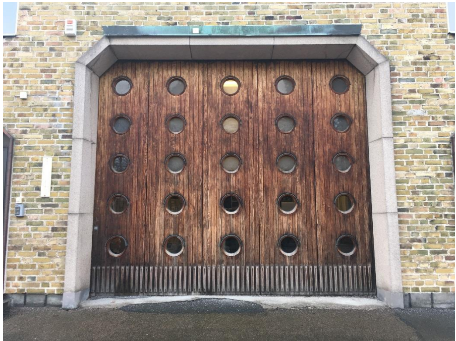
Figur 23 Vikporten med krysshamrad granitombfättning. Notera den räfflade nederdelen.
