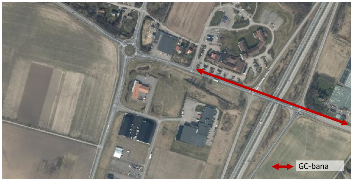
Figur 17. Ny separerad gång- och cykelbana.
