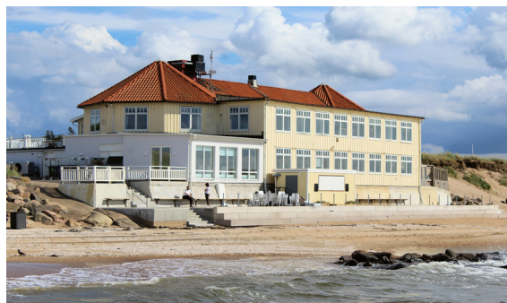
Fig 8. Klitterhus sett från befintlig badbrygga.
