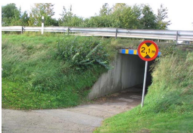
Figur 4 Cykeltunnel som sluter tätt in på cykelväg. Det är svårt att se vad som finns vid sidan av där man kommer ut ur tunneln. Tunneln finns i Munka-Ljungby. Foto: Ann-Kristin Wüinberg, 2008.
