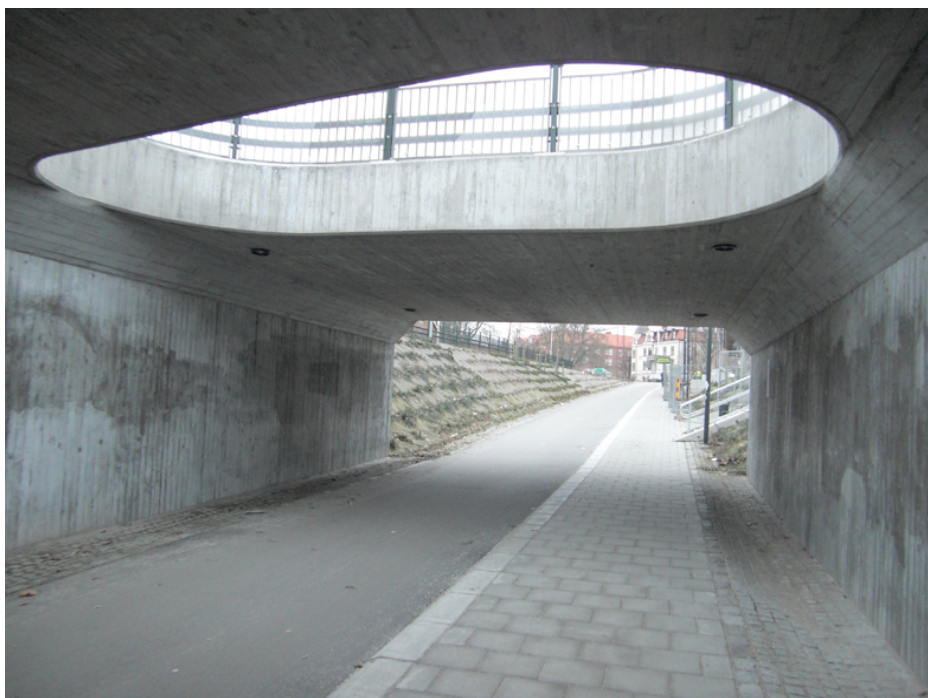
Figur 8 Gång- och cykeltunnel i Lund som utformats med ett hål i taket för att få ett bra ljusinsläpp. Foto: Hanna Fors, 2009.
