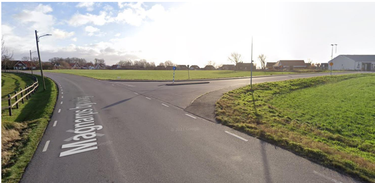
Figur 9 Gångbana längs Röstisvägen leder ut till Magnarps byaväg där anslutande gångbana saknas. (foto från google streetview)
