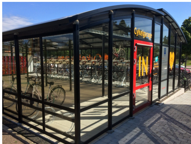
Cykelgarage vid Ängelholms station.
