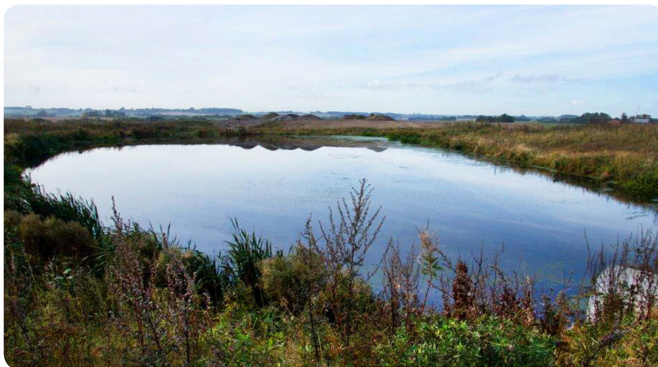
Bild 1: Dagvattenmagasin i Tofta.
