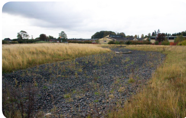
Bild 6. Makadamfyllt dike för lågvattenföring som försetts med en genomsläpplig beläggning.
