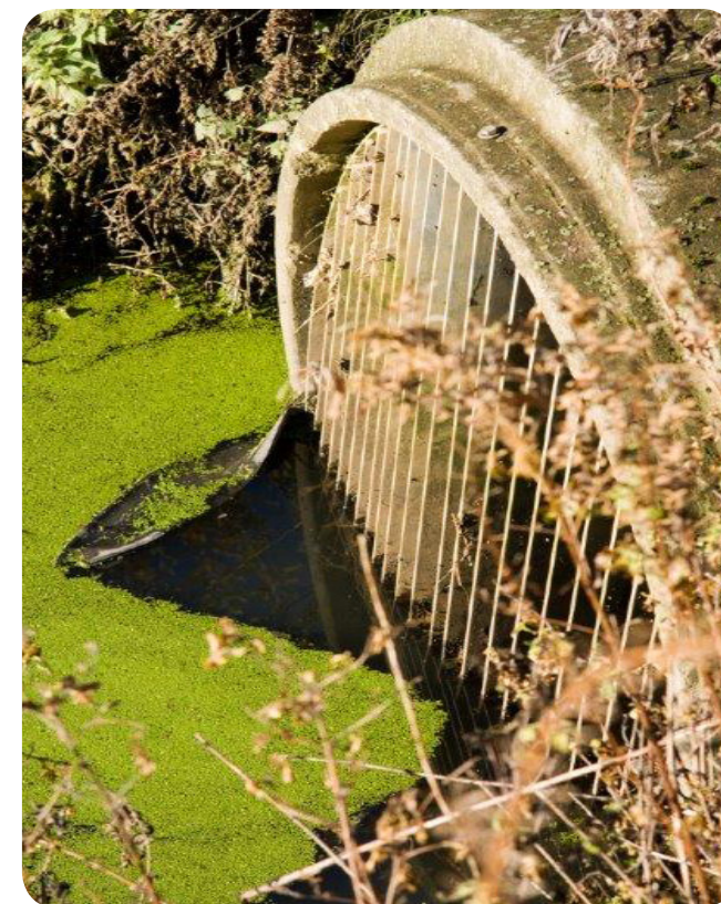
Bild 12: Mynningsrör till dagvattenmagasin i Åkerslund.
