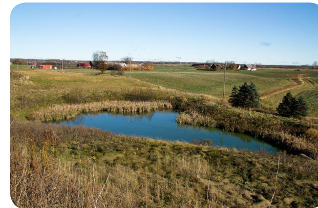
Bild 9: Dagvattenmagasin vid Älvdalens industriområde, Ängelholm, försett med flödesregulator för reglering av utflödet från dammen.
