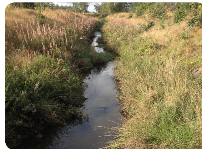
Bild 5. Exempel på öppen dagvattenhantering i bäck/dike.
