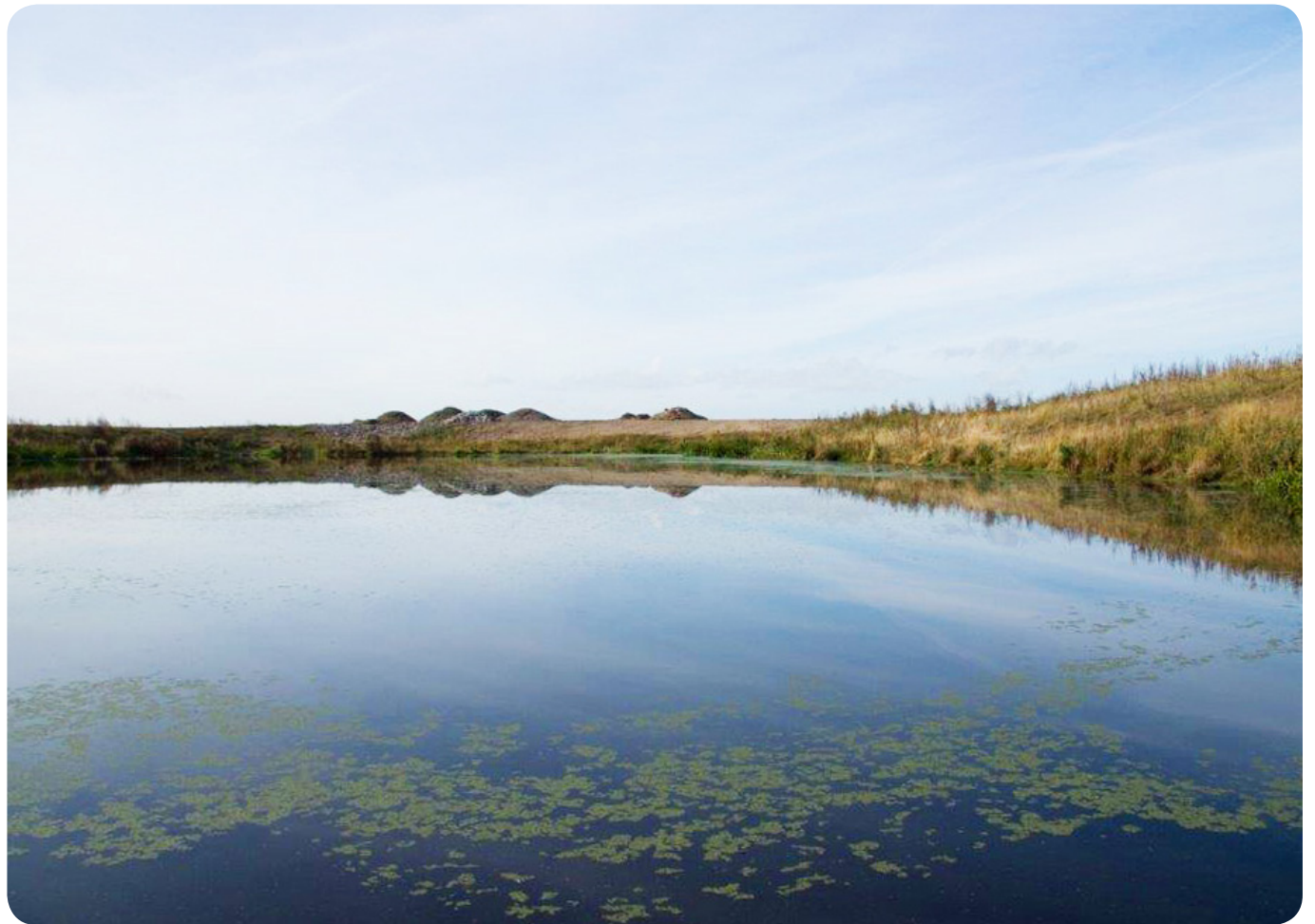
Bild 13: Dagvattenmagasin i Tofta.
