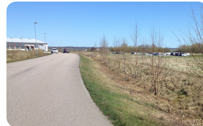
Bild 8: Öppna diken eller helst bredare svackdiken kan användas för transport och viss rening av dagvattnet från vägar m.m.
