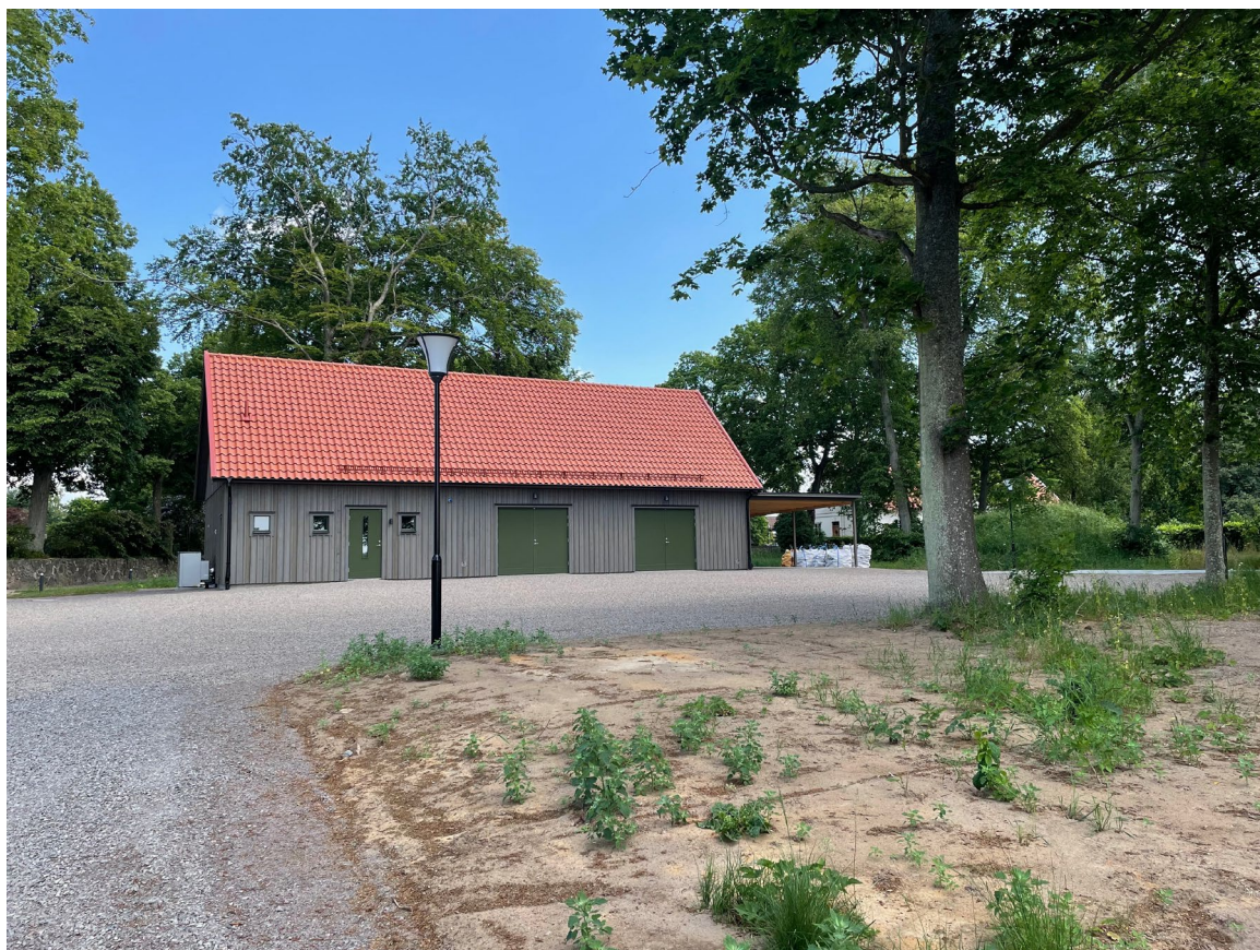
Figur 4: Vaktmästeribyggnad för församlingens verksamhet.
