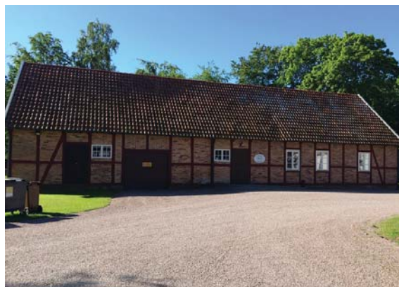
Foto: Det gamla stallet, nuvarande förskola.
