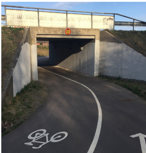
Fig. 5. Befintlig tunnel under Örkelljungavägen
