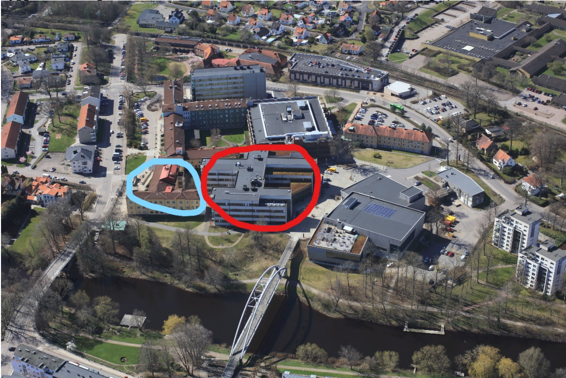
Figur 2. Flygfoto (taget från norr mot söder) över aktuellt område erhållet av Hälsostaden Ängelholm AB 2023-09-11. Aktuell yta med befintlig byggnad inringad i blått och byggnad färdigställd 2018 med kulvert inringad i rött.
