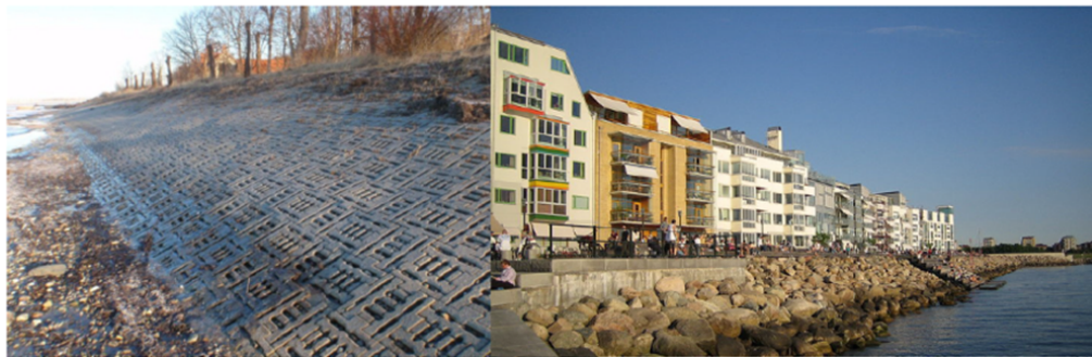
Strandskoning med flexplattor
