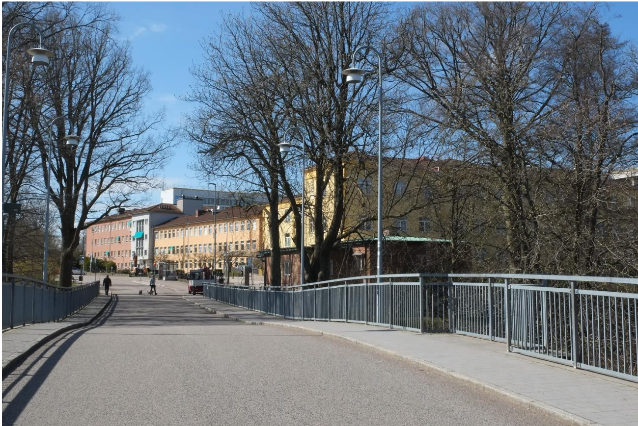
Figur 11. Den sammanhängande fasadsträckan i gula, röda och beige kulörer skapar en karaktärsfull inramning till Ängelholms södra infart och speglar sjukhusets utveckling från 1870-talet till 1950-talet. Foto taget från Carl XV:s bro.
