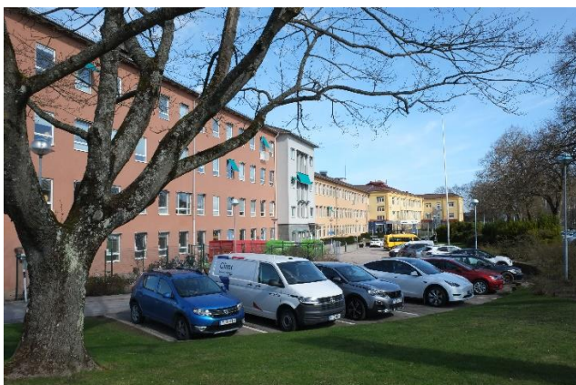
Figur 12. Fasadsträckan utmed Södra vägen, foto åt norr.
