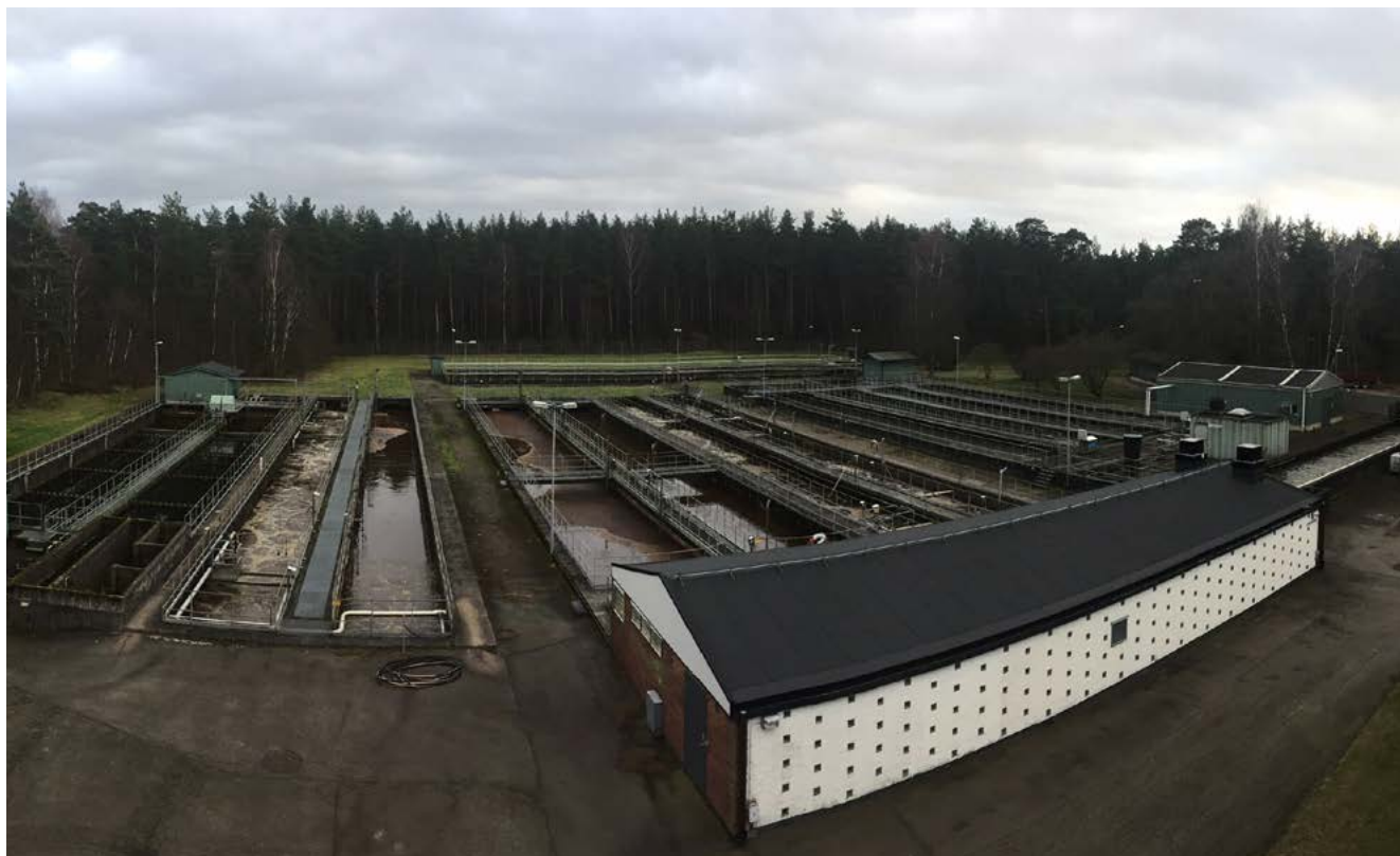
Foto: Roland Andersson – Ängelholms avloppsreningsverk före utbyggnad
