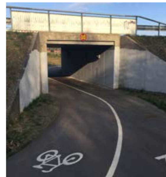
Fig. 5. Befintlig tunnel under Örkelljungavägen
