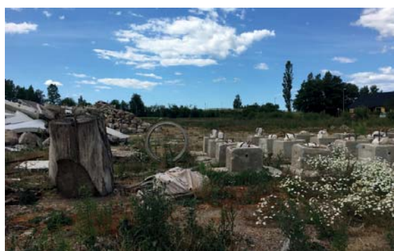
Rivningsmassor har lämnats kvar på fastigheten.
