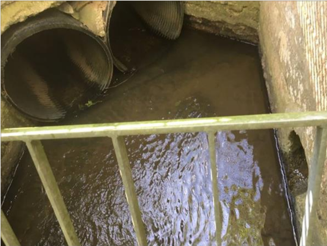
Figur 8. Inlopp till de två dagvattenledningar, karterade i Figur 7. Se markering i Figur 7 för lokalisering.
